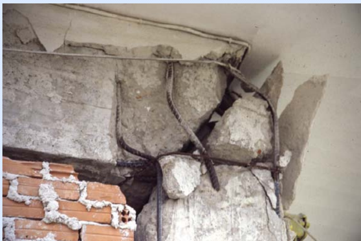
Αστοχία εξωτερικού κόμβου και πρακτική απώλεια στήριξης δοκού
