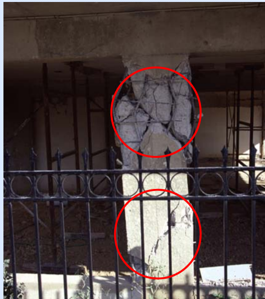
Διατμητική αστοχία υποστυλώματος πάνω & κάτω με λυγισμό ράβδων
