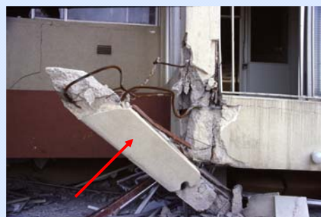
Ίδιο κτίριο, υποστύλωμα ισογείου
