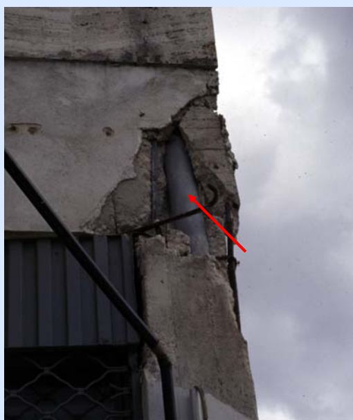
Αστοχία κόμβου και απώλεια περίσφιγξης συνδετήρων λόγω τοποθέτησης υδρορροής εντός του υποστυλώματος
