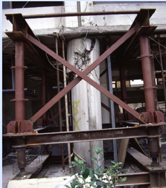
Τρόπος ανόψωσης κτιρίου, με γρύλους
