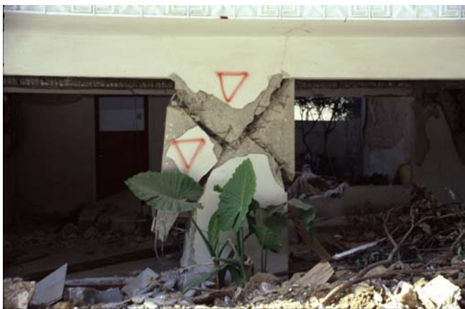
Φωτ. 19 (αρ.): Διατμητική αστοχία τοιχώματος με μεγάλες παραμορφώσεις
