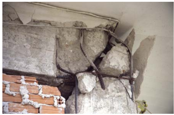
Φωτ. 22 (δεξ.): Αστοχία εξωτερικού κόμβου και πρακτική απώλεια στήριξης δοκού
