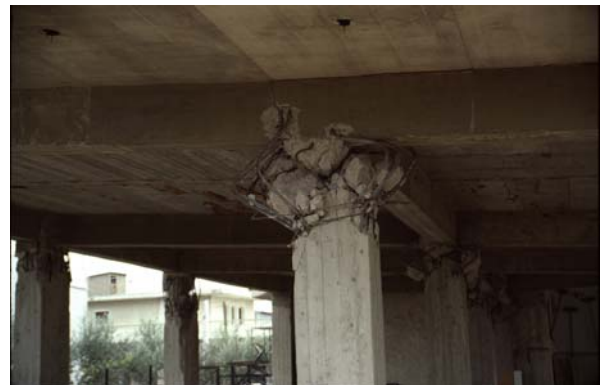
Φωτ. 10,11 (αρ. & δεξ.): Διατμητική αστοχία πάνω άκρου υποστυλωμάτων λόγω απουσίας συνδετήρων. Ο μανδύας συνδετήρων έφτανε μέχρι 0.50 m κάτω από τις δοκούς
