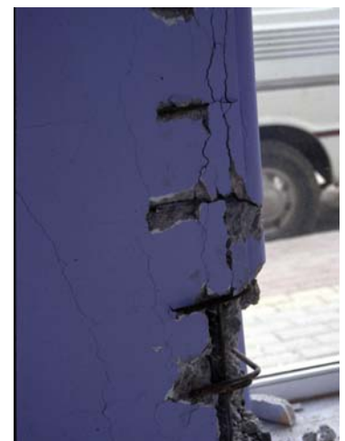
Φωτ. 12,13 (αρ. & μέσο): Άνοιγμα συνδετήρων με κάμψη άκρων κατά 90° μετά την αποφλοίωση της επικάλυψης των οπλισμών Φωτ. 14 (δεξ.): Εκτίναξη γωνίας διατομής σκυροδέματος λόγω μη συγκράτησης του κατακόρυφου οπλισμού στη γωνία συνδετήρα
