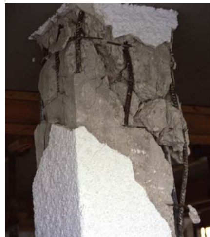
Φωτ. 6 (αρ.): Διατμητική αστοχία υποστυλώματος πάνω & κάτω με λυγισμό ράβδων και θραύση λεπτών & αραιών συνδετήρων
