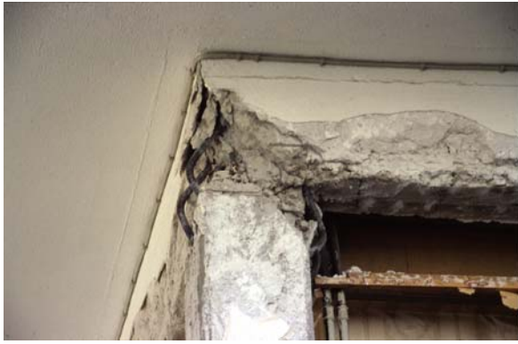
Φωτ. 21 (αρ.): Αστοχία εξωτερικού κόμβου με μείωση ακαμψίας του
