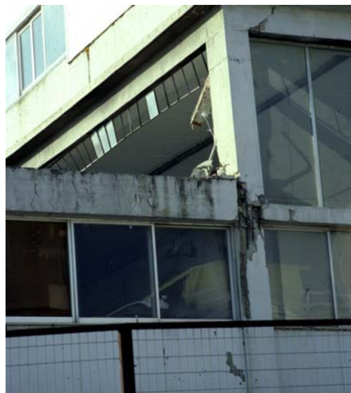
Φωτ. 23 (αρ.): Αστοχία κόμβου και απώλεια περίσφιγξης συνδετήρων λόγω τοποθέτησης υδρορρόης εντός του υποστυλώματος
