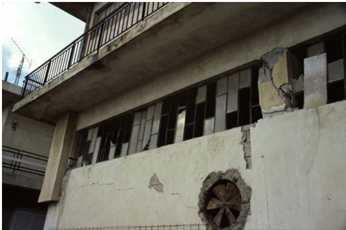
Φωτ. 17 (αρ.): Αποτελεσματικότητα επισκευής με τοπικό μανδύα κοντού υποστυλώματος βλαμμένου από προηγούμενο σεισμό
