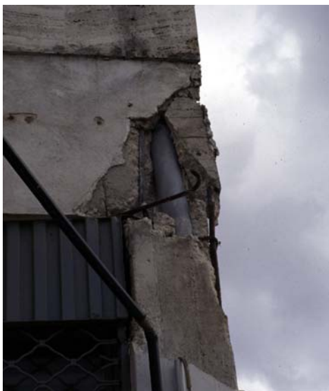
Φωτ. 23 (αρ.): Αστοχία κόμβου και απώλεια περίσφιγξης συνδετήρων λόγω τοποθέτησης υδρορρόης εντός του υποστυλώματος
