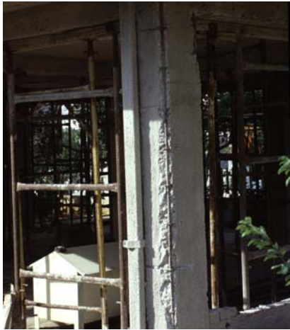
Φωτ. 1 (αρ.): Αποφλοίωση σκυροδέματος επικάλυψης
