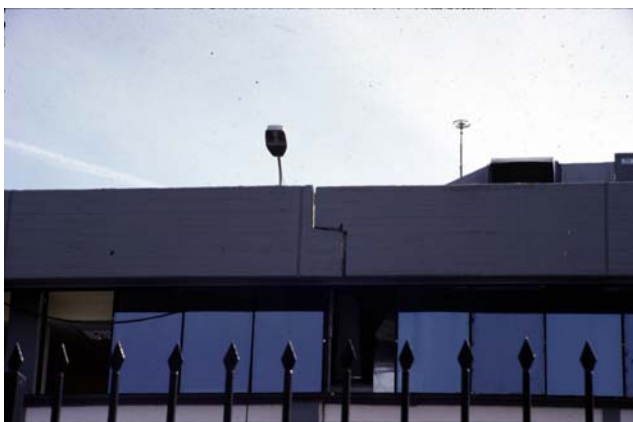
Φωτ. 25 (αρ.): Μικρό άνοιγμα αρμού διαστολής από οριζόντια σεισμική μετακίνηση σε κτίριο μεγάλης κάτοψης
