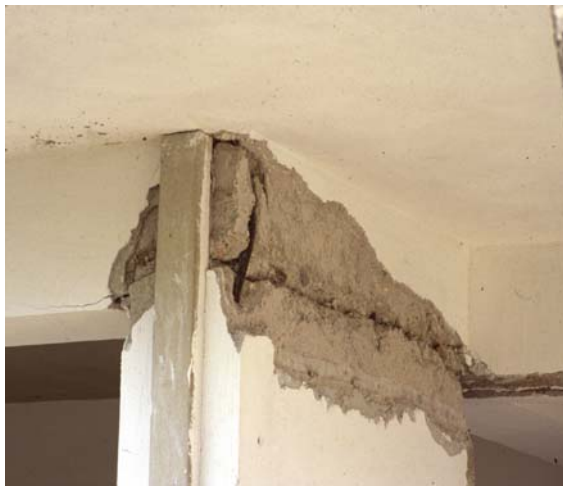
Φωτ. 4 (αρ.): Ανεπαρκής αγκύρωση κάτω ράβδων δοκού λόγω σκυροδέτησης υποστυλώματος πάνω από τη μασχάλη δοκού
