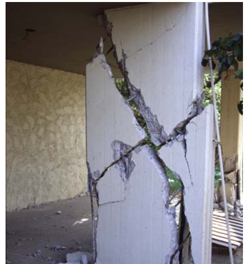
Φωτ. 17 (αρ.): Αποτελεσματικότητα επισκευής με τοπικό μανδύα κοντού υποστυλώματος βλαμμένου από προηγούμενο σεισμό
