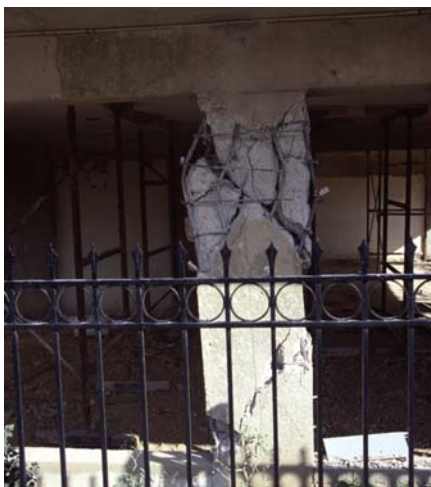
Φωτ. 6 (αρ.): Διατμητική αστοχία υποστυλώματος πάνω & κάτω με λυγισμό ράβδων και θραύση λεπτών & αραιών συνδετήρων
