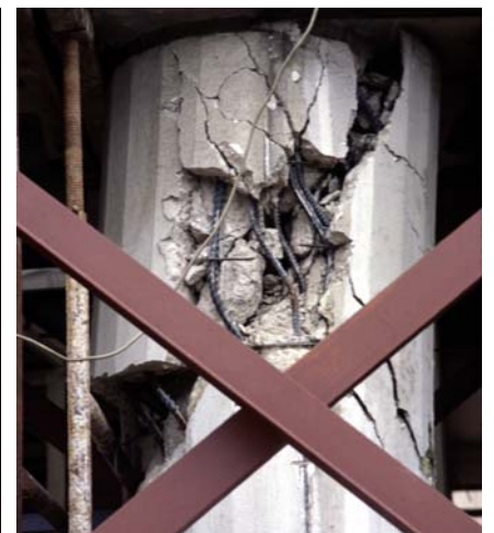
Φωτ. 6 (αρ.): Διατμητική αστοχία υποστυλώματος πάνω & κάτω με λυγισμό ράβδων και θραύση λεπτών & αραιών συνδετήρων
