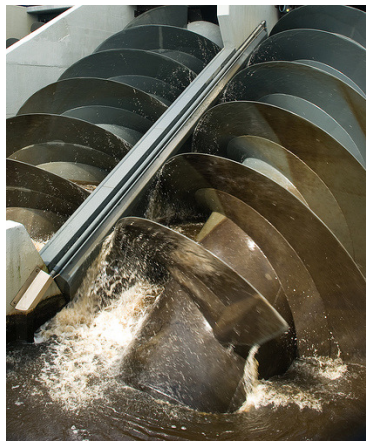
Οι σύγχρονες αντλίες με κοχλία του Αρχιμήδη στην περιοχή του Kinderdijk σε λειτουργία
