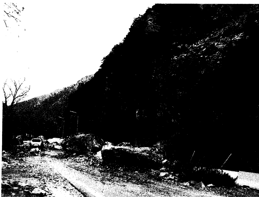
Φωτο 20. Ο χώρος του οδοστρώματος με τις βραχομάζες που αστόχησαν από δυτικά.
