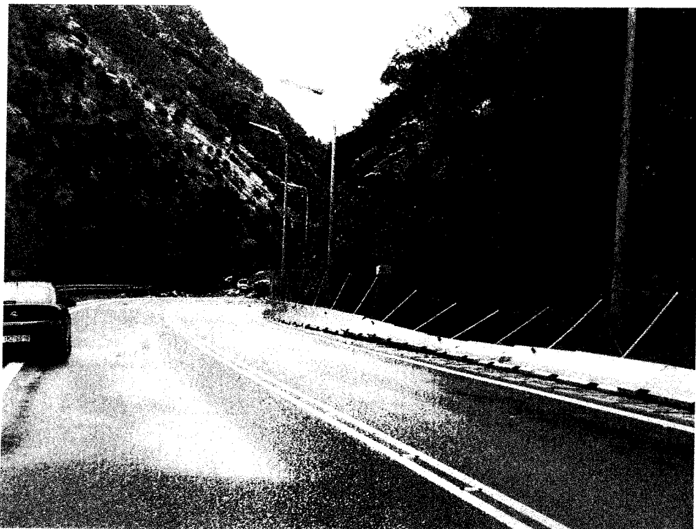
Φωτο 21. Ανατροπή του φράκτη από new jersey και πλέγμα που προκλήθηκε από την κατάπτωση στο οδόστρωμα των βραχομαζών της αστοχίας, αλλά σε αρκετή απόσταση από αυτήν.
