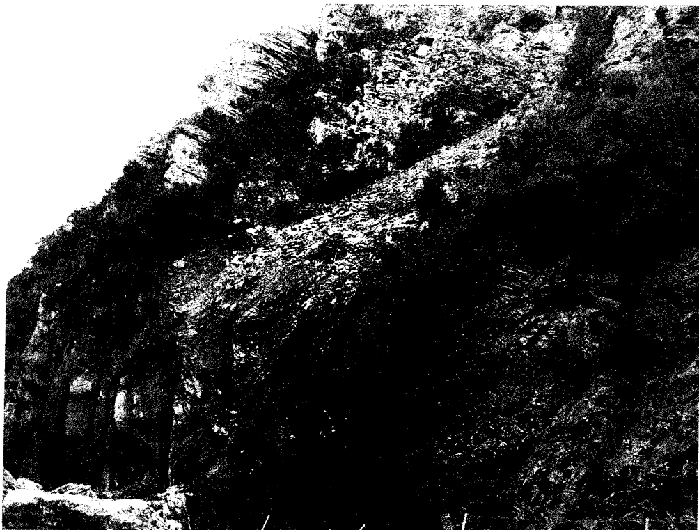
Φωτο 17. Τα τρία κύρια συστήματα ασυνεχειών στο χώρο της αστοχίας. Η στρώση αντίρροπη με μικρές κλίσεις στο πρανές και τα δύο υποκατακόρυφα που διακρίνονται καλά στο κάτω τμήμα του πρανούς.
