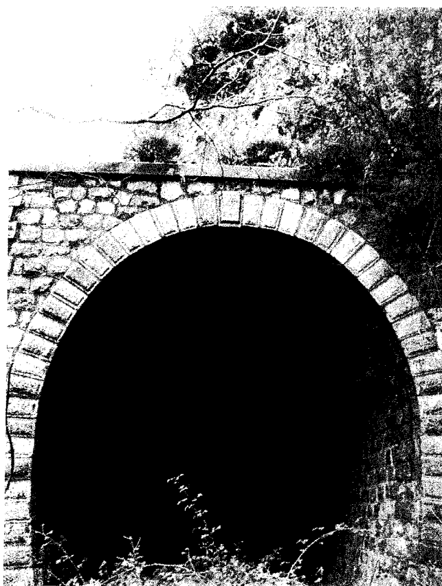
Φωτο 22. Η ανατολική είσοδος της μεγάλης σήραγγας της παλαιάς γραμμής του τραίνου στην κοιλάδα των Τεμπών. Διακρίνεται η λίθινη επένδυσή της.
