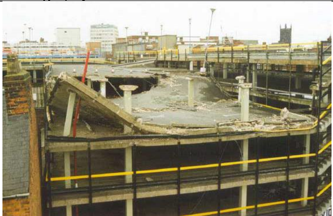
Σχήμα 11: Αστοχία διάτρησης σε χώρο στάθμευσης: μια έκταση 15*15m του δώματος κατέρρευσε στις 3.00π.μ. της 20 ης Μαρτίου 1997 όταν η αστοχία από διάτρηση ενός υποστυλώματος οδήγησε στην αλυσωτή οκτώ γειτονικών υποστυλωμάτων. Ευτυχώς ο χώρος ήταν κενός και δεν υπήρξαν θύματα. Από το: Jonathan G M Wood, «Pipers Row Car Park, Wolverhampton, Quantitative Study of the Causes of the Partial Collapse on 20th March 1997».
