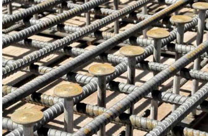
Σχήμα 15: Οπλισμός διατρήσεως με ήλους διπλής κεφαλής. (Φωτογραφία από το διαδίκτυο)..
