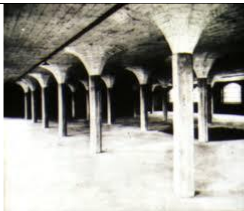
Σχήμα 13: Μυκητοειδής πλάκα. Σκεφτείτε το κόστος διαμόρφωσης του κιονόκρανου (Φωτογραφία από το διαδίκτυο)..
