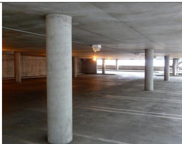
Σχήμα 14: Πλάκα χωρίς δοκούς (flat slab) (Φωτογραφία από το διαδίκτυο).
