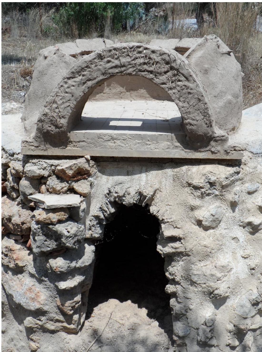
Μετά το ψιλόβροχο τα πάντα γέμισαν λάσπη. Διακρίνεται η κατασκευαστική τσαχπινιά-θέση για τον φραπέ του φούρναρη πάνω αριστερά της καμάρας.
