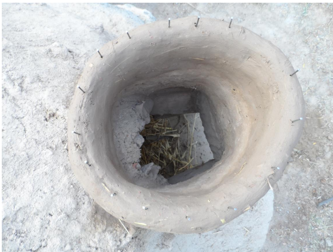
Κατασκευή της καμινάδας με επάλληλες ζώνες πηλού (με άχυρο και θρυμματισμένα με βαριοπούλα τούβλα) και καρφιά-αναμονές.
